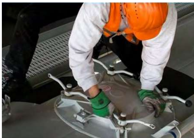
En todas las operaciones de carga, descarga y movimiento de pellets se deben extremar las precauciones para evitar las fugas.
